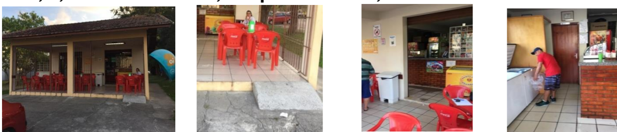
Figura 1, 2, 3 e 4 – Fachada, rampa de acesso, níveis e acesso ao sanitário
